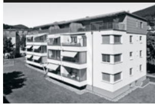
46 RICKENBACH St.Laurentiusstrasse 6-20, Wendelinweg 1-3 Baujahr 1986
