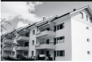
41 HAUSEN Hauptstrasse 4/6/12/14, Unterdorfstrasse 11-15 Baujahr 1984
