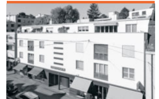
22 BINNINGEN Hauptstrasse 50 Baujahr 1986
