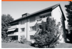
42 ISLIKON Alte Landstrasse 17-19 Baujahr 1983
