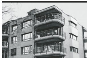
30 BASEL Chrischonastrasse 38 Baujahr 1983
