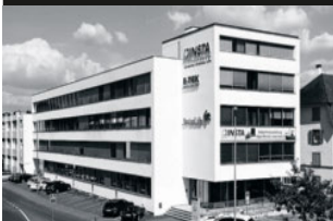
1 ALLSCHWIL Binningerstrasse 95, Fabrikstrasse 2 Baujahr 1964
