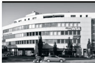
6 BASEL Münchensteinerstrasse 127 Baujahr 1993
