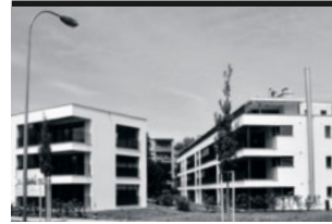
51 WETZIKON Ettenhauserstrasse 29-33 Baujahr 1982/2013
