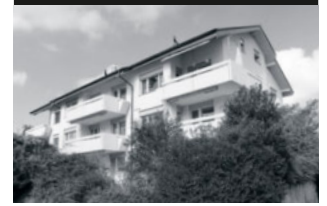
48 RUDOLFSSTETTEN Hofackerstrasse 44-48 Baujahr 1987
