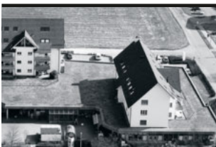
23 LUPFIG Flachsacherstrasse 15/17/19, Ahornwegli 2 Baujahr 1993
