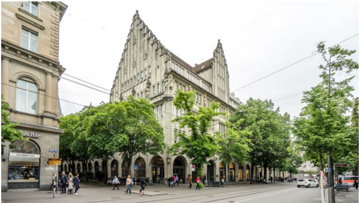
Aussenansicht, Blick von Bahnhofstrasse
